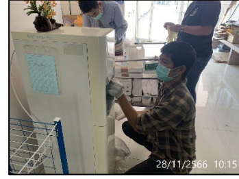
ภาพที่ ค-15 เปลี่ยนไส้กรองน้ำดื่มที่ตู้กดน้ำดื่มภายในโรงพยาบาล ระหว่างเดือนกรกฎาคม - ธันวาคม 2566
