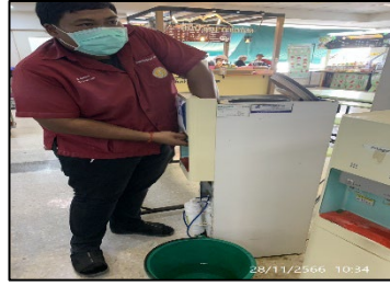
ภาพที่ ค-15 เปลี่ยนไส้กรองน้ำดื่มที่ตู้กดน้ำดื่มภายในโรงพยาบาล ระหว่างเดือนกรกฎาคม - ธันวาคม 2566
