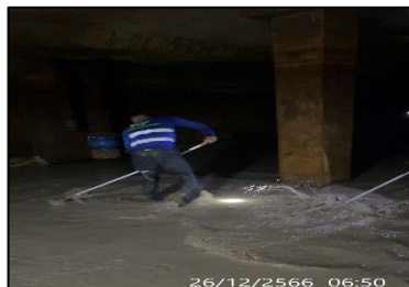
ภาพที่ ค-17 การล้างถังเก็บน้ำประปา ระหว่างเดือนกรกฎาคม - ธันวาคม 2566
