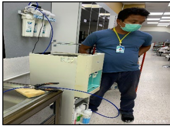
ภาพที่ ค-15 เปลี่ยนไส้กรองน้ำดื่มที่ตู้กดน้ำดื่มภายในโรงพยาบาล ระหว่างเดือนกรกฎาคม - ธันวาคม 2566
