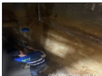
ภาพที่ ค-17 การล้างถังเก็บน้ำประปา ระหว่างเดือนกรกฎาคม - ธันวาคม 2566
