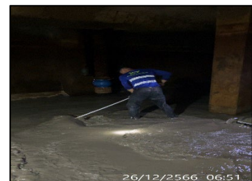
ภาพที่ ค-17 การล้างถังเก็บน้ำประปา ระหว่างเดือนกรกฎาคม - ธันวาคม 2566
