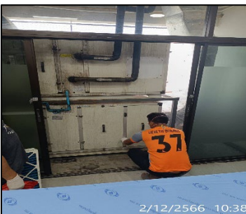
ภาพที่ ค-4 ทำความสะอาดเครื่องปรับอากาศและทำการเปลี่ยน HEPA Filter ระหว่างเดือนกรกฎาคม - ธันวาคม 2566
