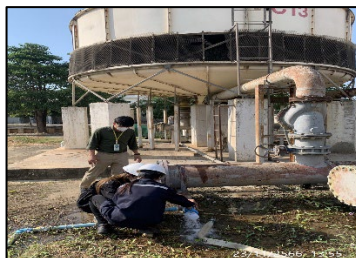
ภาพที่ ค-16 เก็บน้ำตัวอย่าง Cooling Tower ส่งตรวจวิเคราะห์เชื้อลีเจียนเนลลา (Legionella) ระหว่างเดือนกรกฎาคม - ธันวาคม 2566
