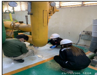
ภาพที่ ค-16 เก็บน้ำตัวอย่าง Cooling Tower ส่งตรวจวิเคราะห์เชื้อลีเจียนเนลลา (Legionella) ระหว่างเดือนกรกฎาคม - ธันวาคม 2566
