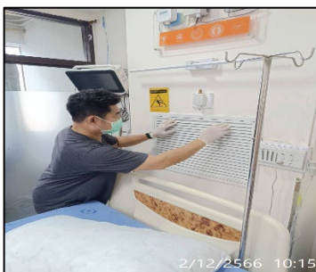
ภาพที่ ค-4 ทำความสะอาดเครื่องปรับอากาศและทำการเปลี่ยน HEPA Filter ระหว่างเดือนกรกฎาคม - ธันวาคม 2566
