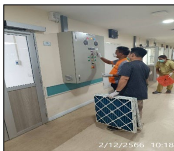
ภาพที่ ค-4 ทำความสะอาดเครื่องปรับอากาศและทำการเปลี่ยน HEPA Filter ระหว่างเดือนกรกฎาคม - ธันวาคม 2566
